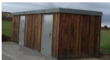
Exemple de poste électrique (PDL et/ou PTR) habillé d'un bardage bois
