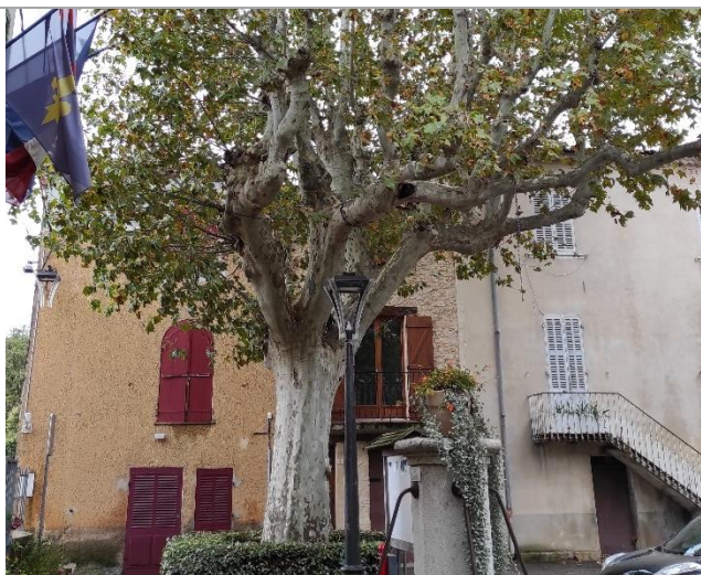
Figure 33 : Platane sur site
