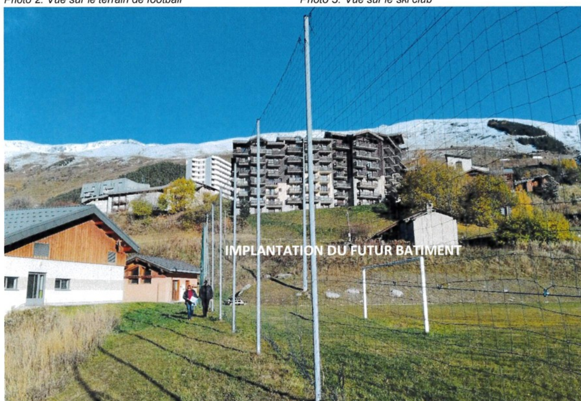
Photo 4. Vue sur le site d'implantation du futur bâtiment
