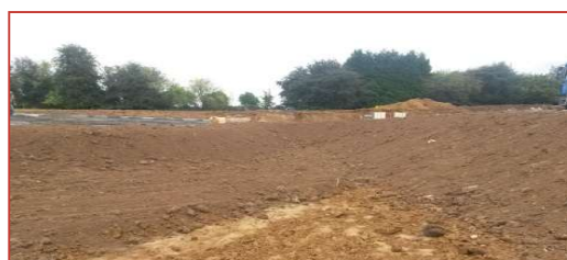
Recapage de la terre végétale
