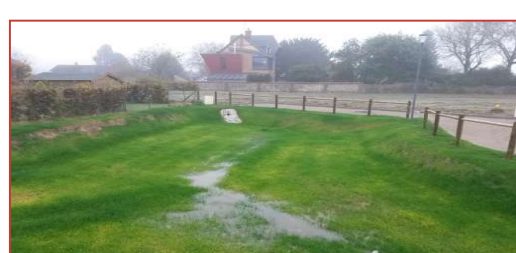
Première mise en eau de l'ouvrage
