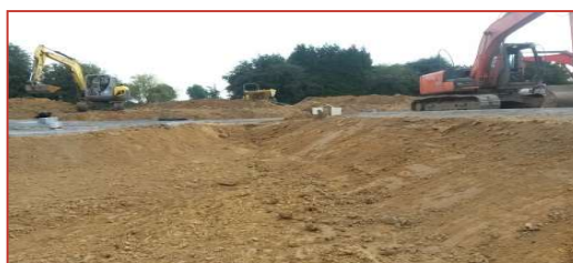
Réalisation des terrassements
