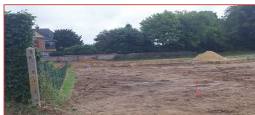
Décapage de la terre végétale
