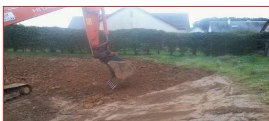
Décompactage et griffage
