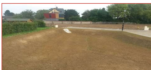
Finition des terrassements
