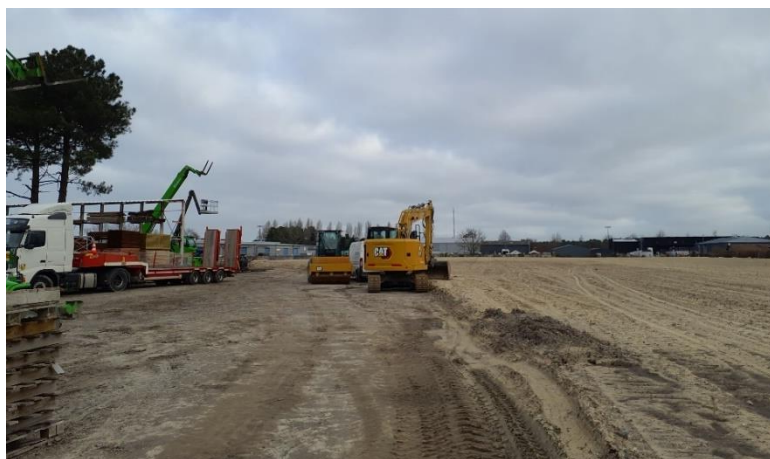
Figure 10 : Présence d'engins de chantier sur le site
