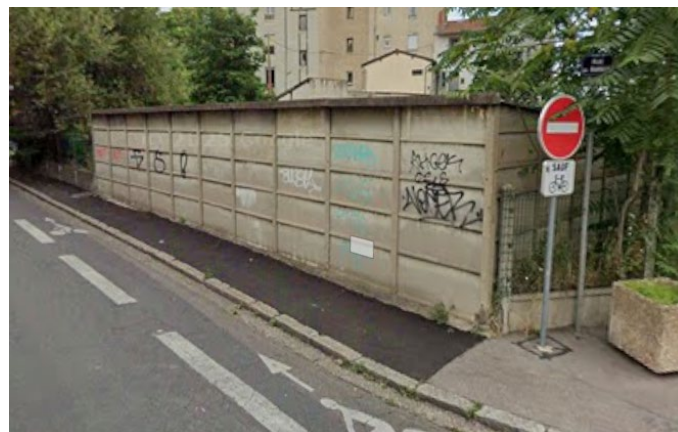
Figure 3 : Garage à démolir rue Gabriel Péri ( Source : Google Street View, juillet 2024)
