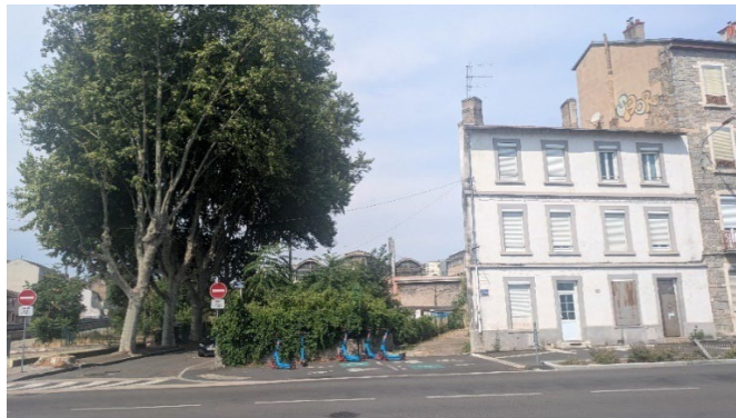
Figure 2 : Immeuble à démolir au 30 quai P. Semard (Soberco environnement, 2026)
