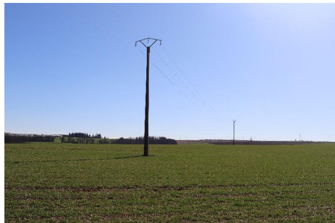
Ligne électrique présente au sein du site d'étude Source : ARTIFEX 2025
