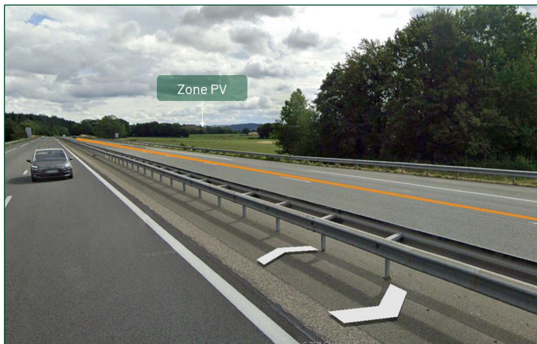
Vue Google Street avec la localisation du tronçon impacté (en orange) – Trajectoire depuis l'Ouest
