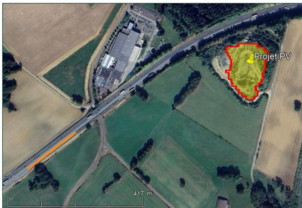
Image satellite avec la localisation du tronçon impacté (en orange) – Trajectoire depuis l'Ouest
