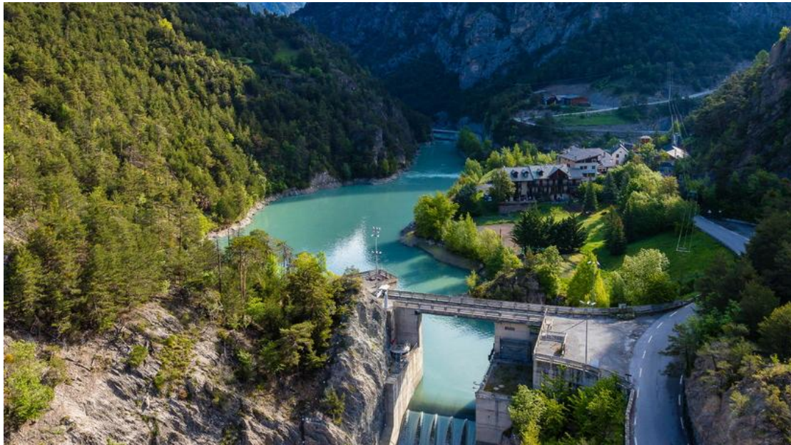
2-Déversés au barrage
