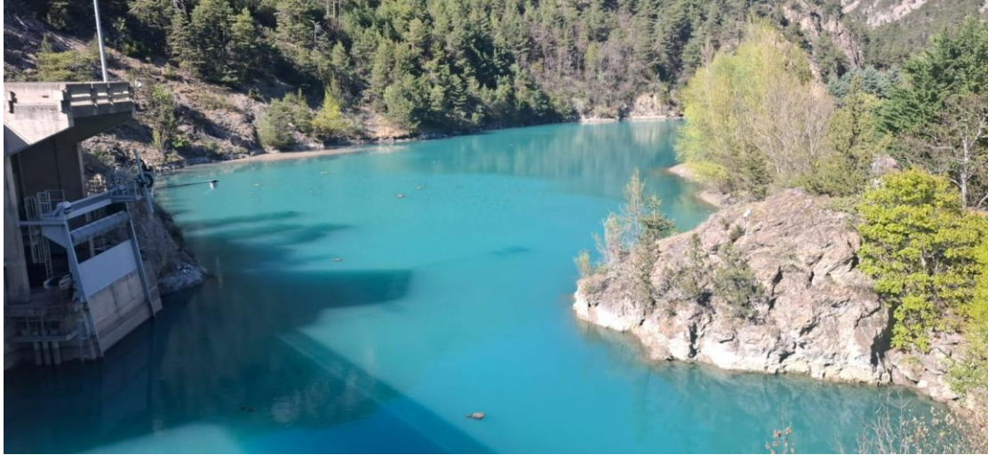
1-Retenue Maison du Roy
