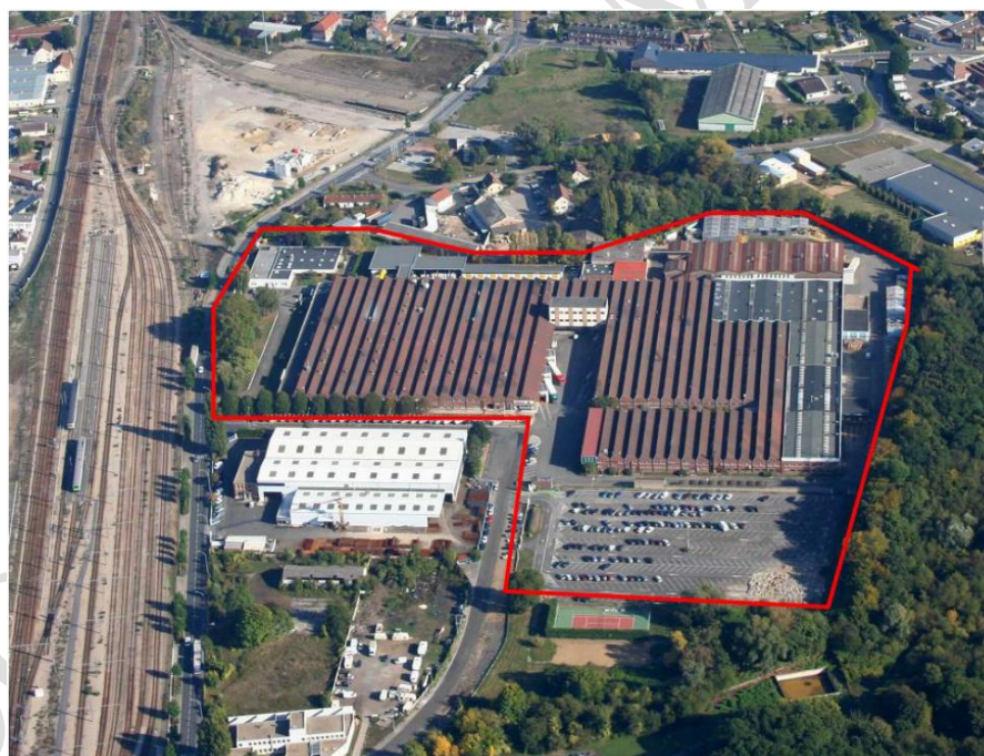
Vue aérienne du site Bosch avant démolition.
