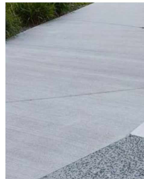
voirie principale : béton balayé
