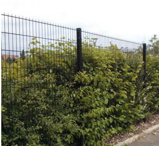
clôture au droit de l'espace logistique
