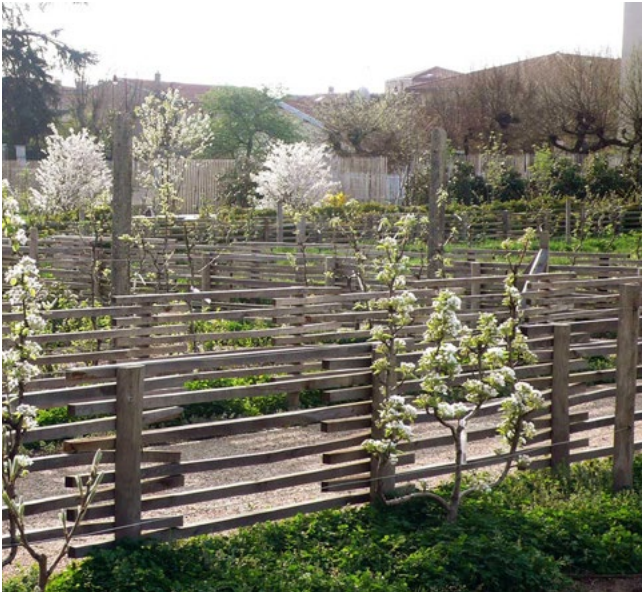
clôture lisse-basse bois d'une hauteur de 1m
