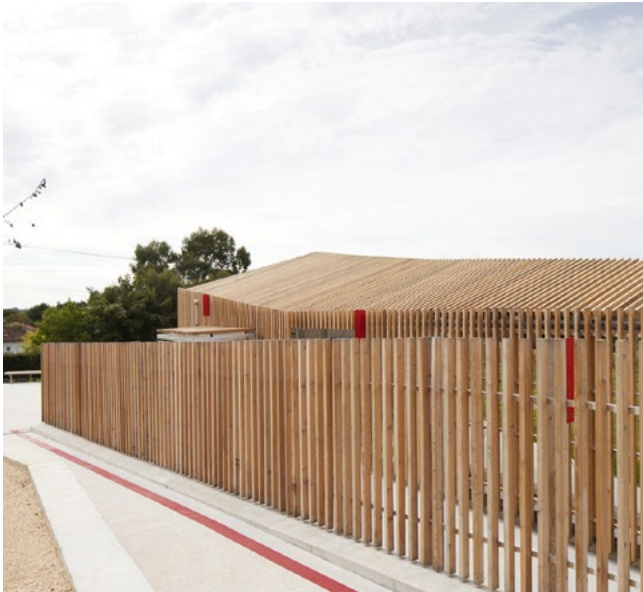
clôture bois PASA d'une hauteur de 1m60
