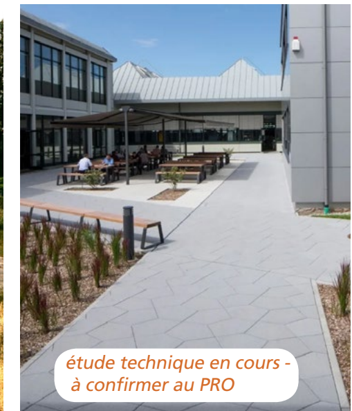
la terrasse et les patios : dalles béton ICI motif atypique («système polygonal» de Kronimus)
