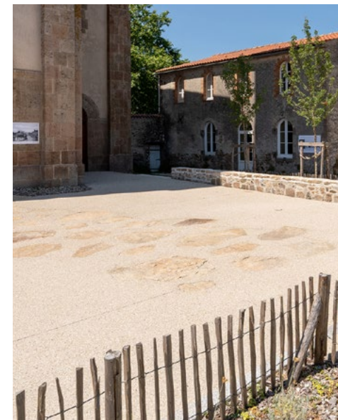
macro dalles incrustées dans le béton désactivé
