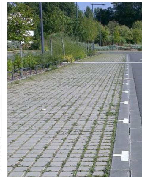
stationnements dans la lisière végétalisée : pavés drainants à ergots béton
