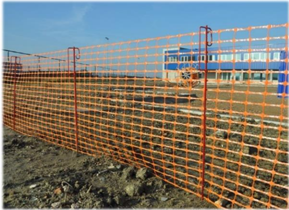
Exemple de grillage de chantier
