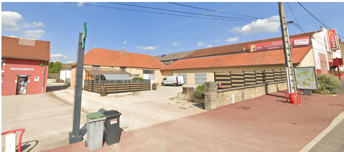
Vue sur l'accès au site, et sur la Cave, depuis la RD973 – Google 08/2023
