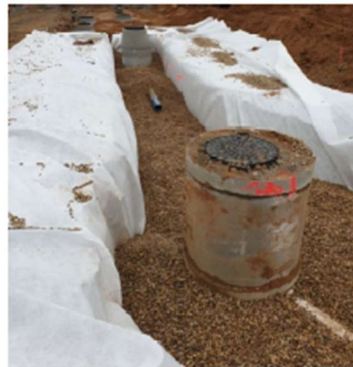
FIGURE 32 : EXEMPLE DE TRANCHEE DRAINANTE
