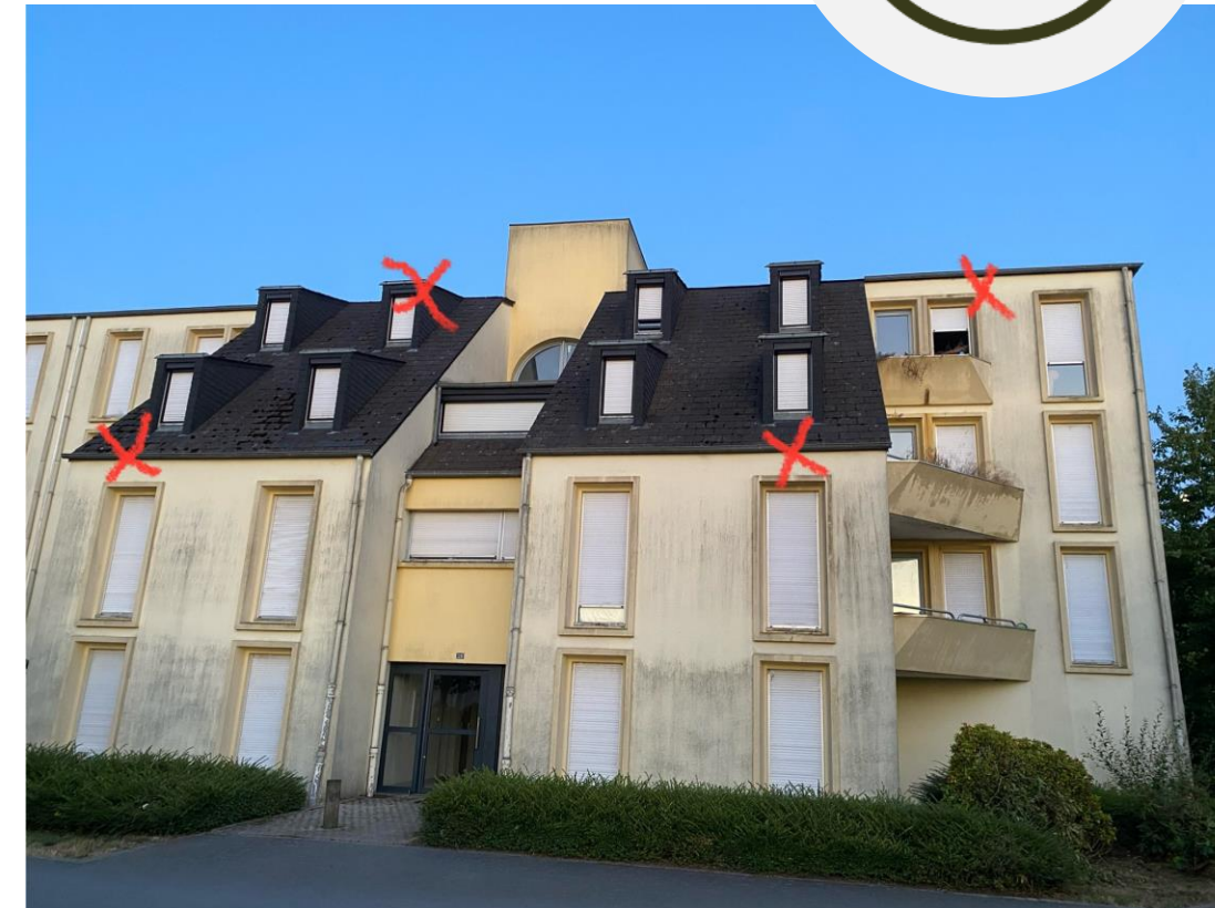
Bâtiment sud-ouest à reproduction de martinet noir
