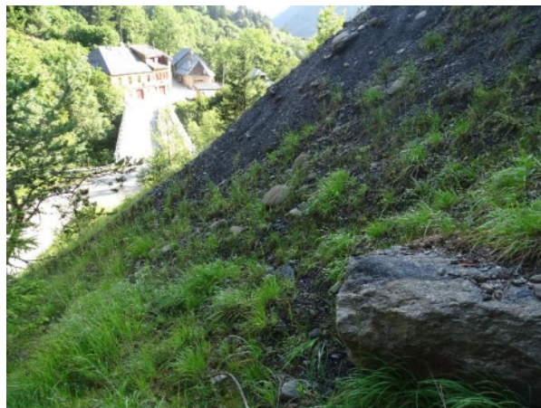
Type de formation végétale présente sur le talus et incluant quelques patches d'habitat des suintements
