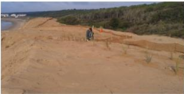
Pose de filets-coco et plantation d'oyats - 2019
