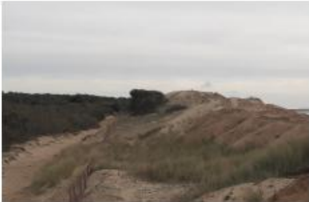
Dune de Longeville avant travaux - 2019
