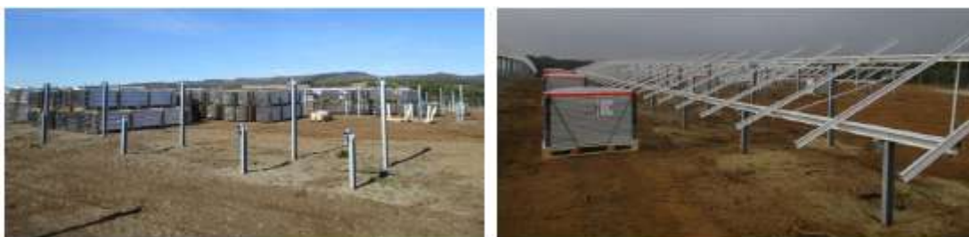
Photographies de la pose des supports
