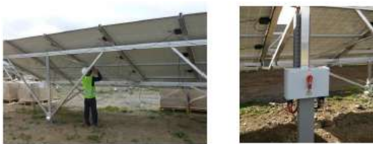
Photographies du câblage des panneaux (gauche) et du boîtier de raccordement (à droite)
