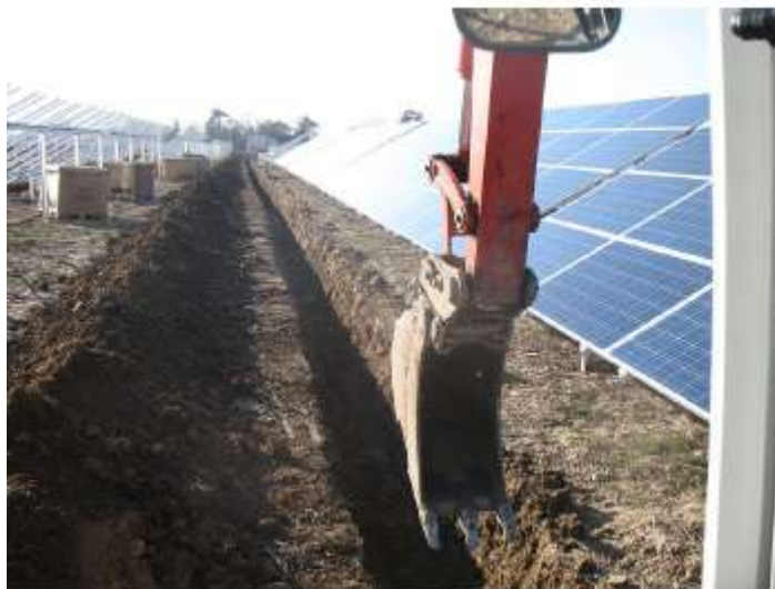
Tranchée pour le passage des câbles
