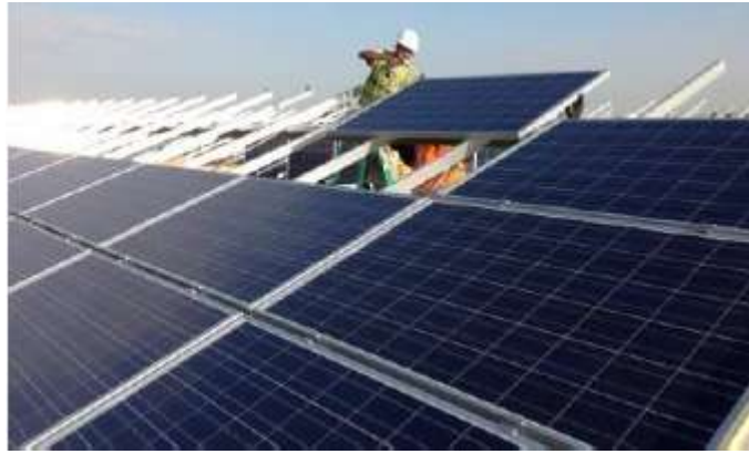
Photographie pose des panneaux sur les supports
