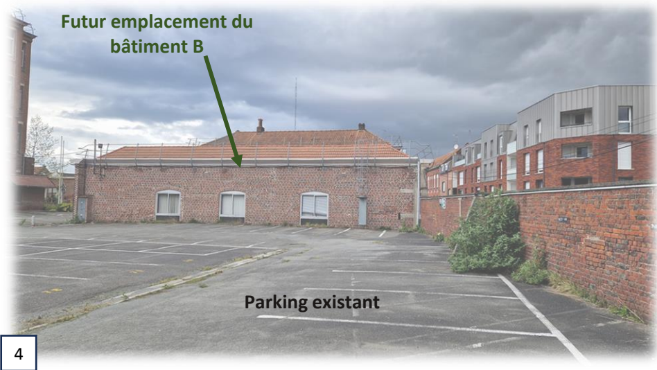
Vue sur l'emplacement des futurs logements (Bâtiment B) situé au Nord de la zone de projet.
