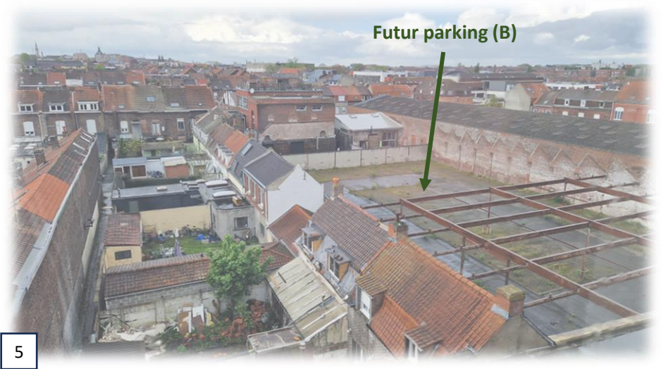
Vue sur le futur parking en aérien (B) au Nord-Ouest de la zone d'étude.
