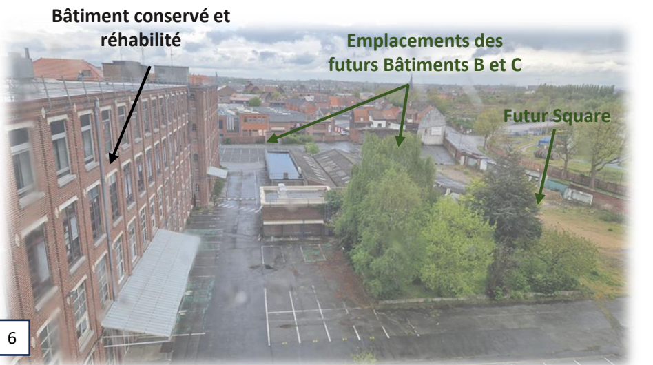
Vue sur la partie Sud du projet depuis la Tour du bâtiment conservé et réhabilité dans le cadre du projet.
