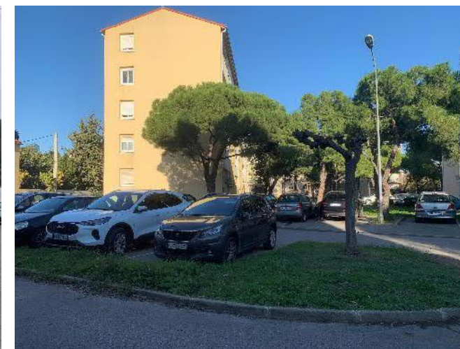
Parking devant le pignon du 1404 (11/2024)
