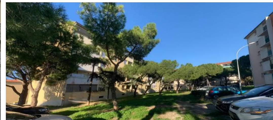
Les espaces verts entre les bât. 1404, 1408.6 et 1408.8 (11/2025)
