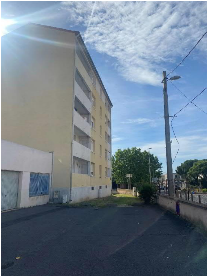
Vue bat 1405.10 coté chemin de la coste (05/2024)
