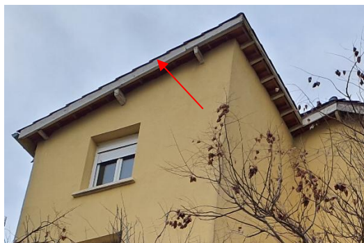
Espace entre les tuiles et la partie boisée de la toiture d'un immeuble qui permet potentiellement aux chiroptères d'accéder sous les tuiles pour gîter (© Biotope).
