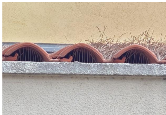
Dispositif anti-oiseaux en place sous les tuiles des toitures des bâtiments de la résidence Pasteur (©Biotope).
