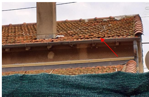
Espaces situés sous les tuiles des maisons de la résidence Petit Versailles et qui pourraient être utilisés par les chiroptères pour gîter (pipistrelles en particulier) (©Biotope).
