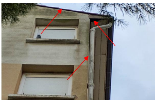
Ouverture dans le dessous en bois de la toiture, interstice sous les tuiles et derrière de gouttière situés au niveau d'un immeuble et favorables aux chiroptères pour gîter (en particulier les deux premiers éléments cités) (©Biotope).
