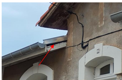
Interstice situé entre les tuiles et le dessous en bois de la toiture d'une maison et qui est favorable aux chiroptères pour gîter (©Biotope).
