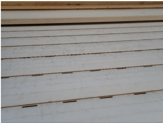
Interstice permettant le passage de chiroptères
