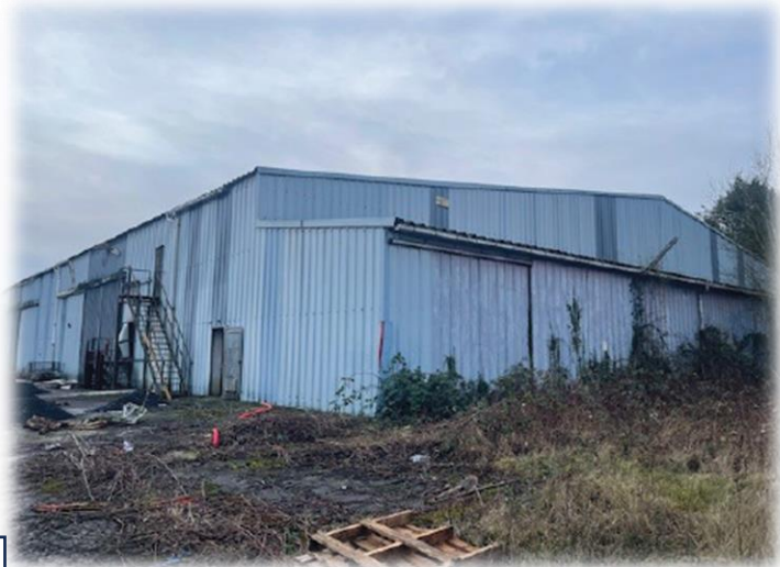
7 Vue sur l'ancien bâtiment existant qui sera démoli dans le cadre du projet
