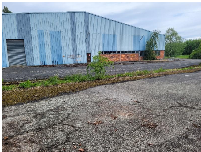
Vue sur le secteur artificialisé / imperméabilisé du site d'étude
