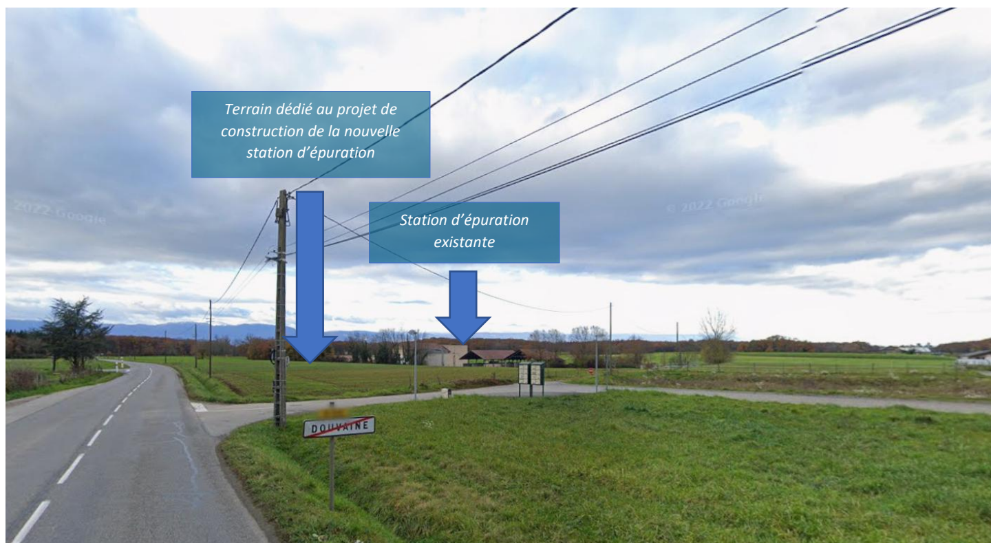
2. La station d'épuration existante et le site dédié à la construction de la nouvelle station d'épuration vus depuis les habitations les plus proches (image Google Maps novembre 2022)
