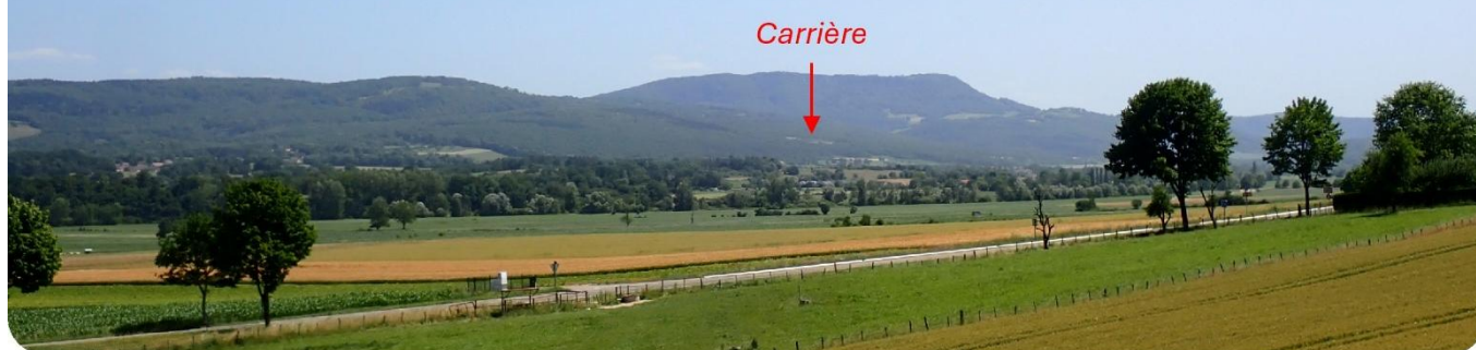
Figure 11 : Vues sur la carrière de Rennes-sur-Loue depuis les zones résidentielles - Planche photographique n°3
