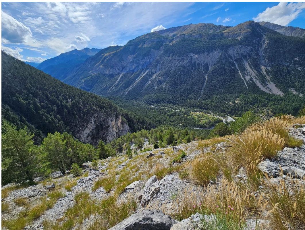
Figure 11 : Photo de la zone d'enfouissement de la canalisation entre les deux derniers lacets de la piste des Acles, vue de l'amont vers l'aval (Source : VALOREM)
