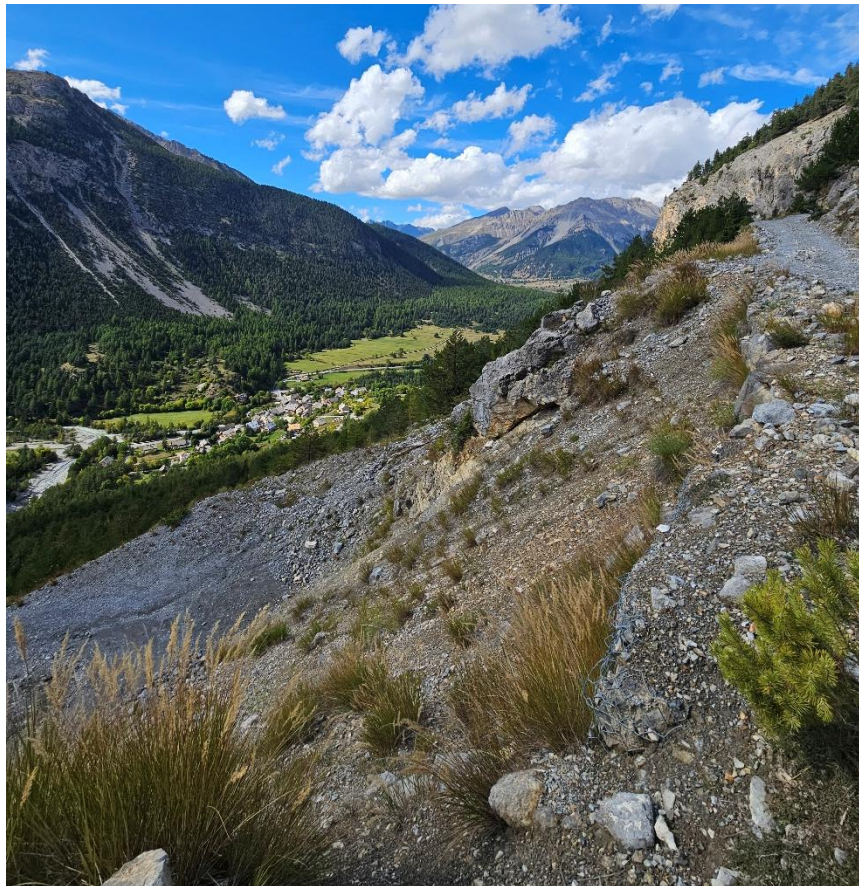
Figure 13 : Photo de la zone d'enfouissement de la canalisation depuis le 9 ème lacet, vue de l'amont vers l'aval (Source : VALOREM)
