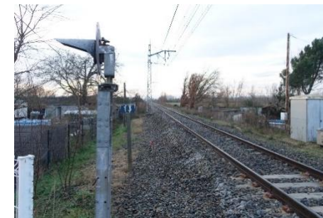
Ligne ferroviaire reliant Toulouse à Foix Source : ARTIFEX 2021
