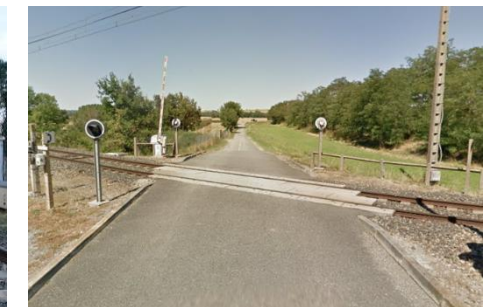
Passage à niveau Source : Google Maps
