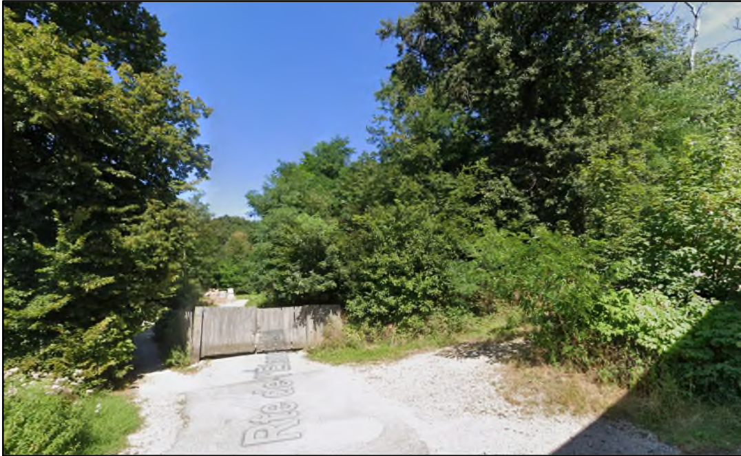
Photographie proche de la future entrée du site (Emplacement 1) – source : google maps, 2024
