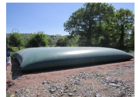
Photographie 8 : Citerne incendie (Source : ENCIS Environnement)
