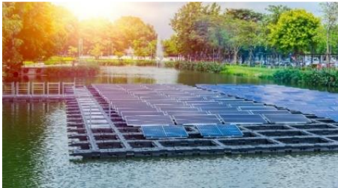
Centrales solaires flottantes
