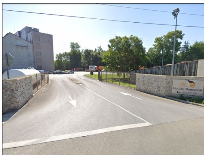
Portail – Entrée du site livraison
