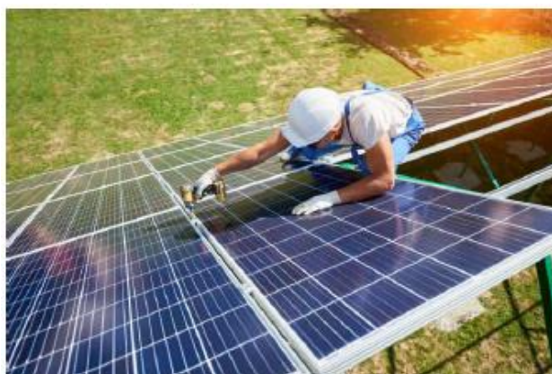
Illustration 10 : Montage des modules
