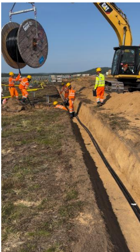
Illustration 11 : tranchée et cheminement de câble
