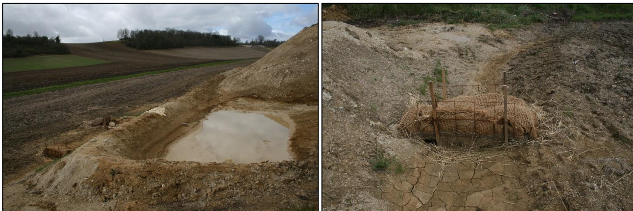
Figure 11 : Bassin de décantation temporaire des eaux de ruissellement en phase de chantier avec filtre à paille en sortie
