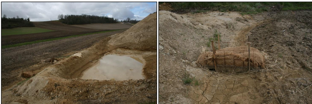
Figure 8 : Bassin de décantation temporaire des eaux de ruissellement en phase de chantier avec filtre à paille en sortie
