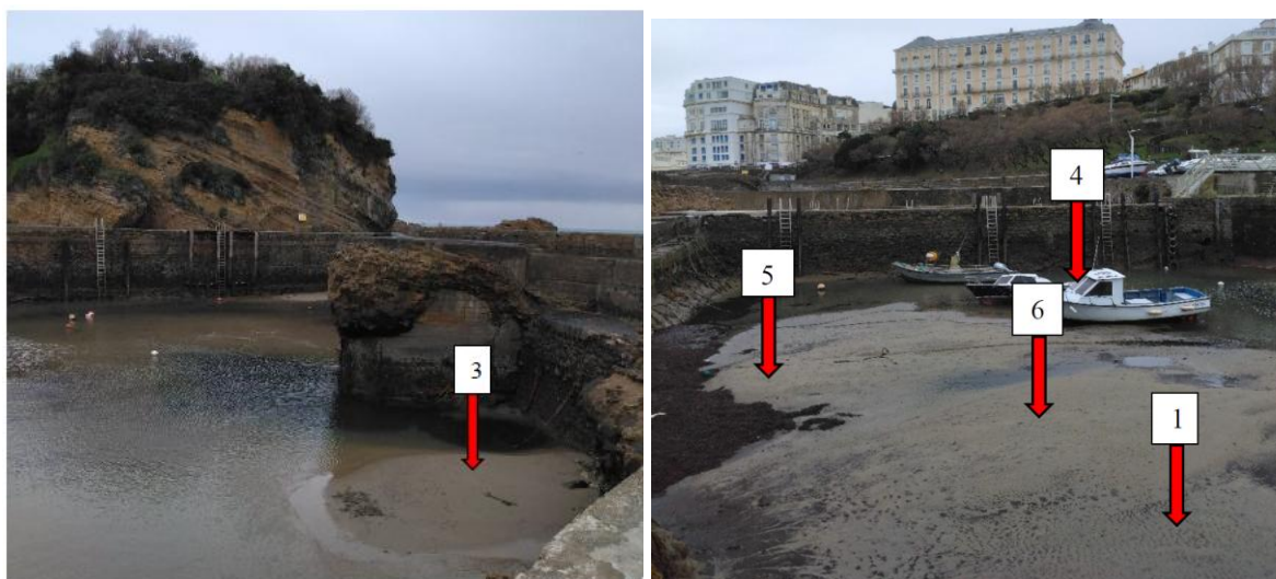
Photo 1 : Photo du sable superficiel au fond du bassin 1 (à gauche) et 2 (à droite) le 07/01/26 (LPL, 2026)
