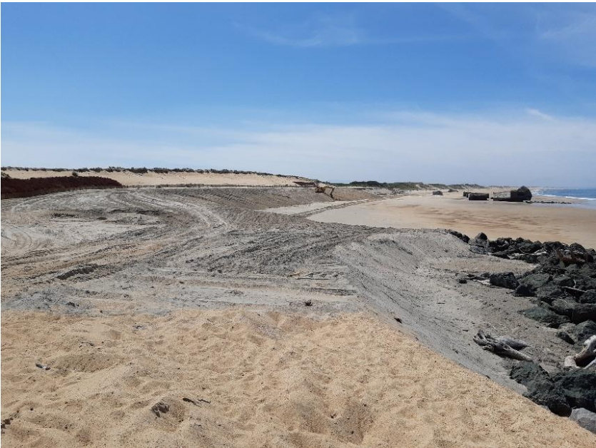
Photo 3 : Exemple du rechargement de sable dragués hydrauliquement et rechargés sur la plage de Santocha à Capbreton (CREOCEAN, 2020)
