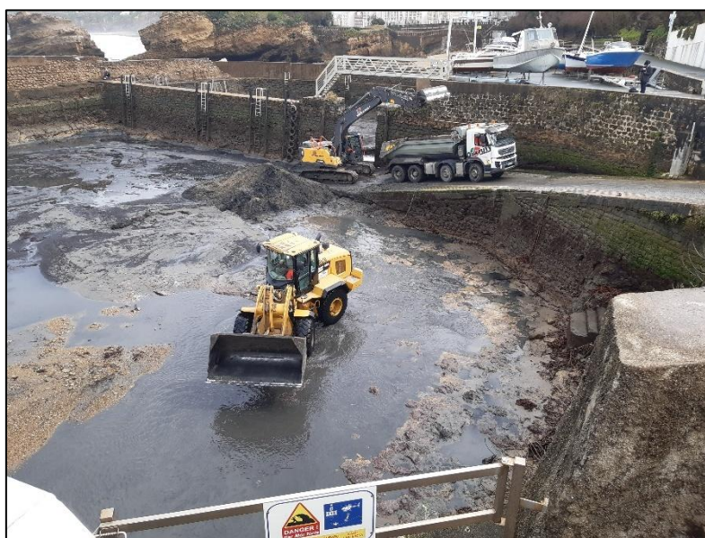
Photo 1 : Pelles mécaniques mise en œuvre dans le port des pêcheurs de Biarritz (Mairie de Biarritz, 2024)
