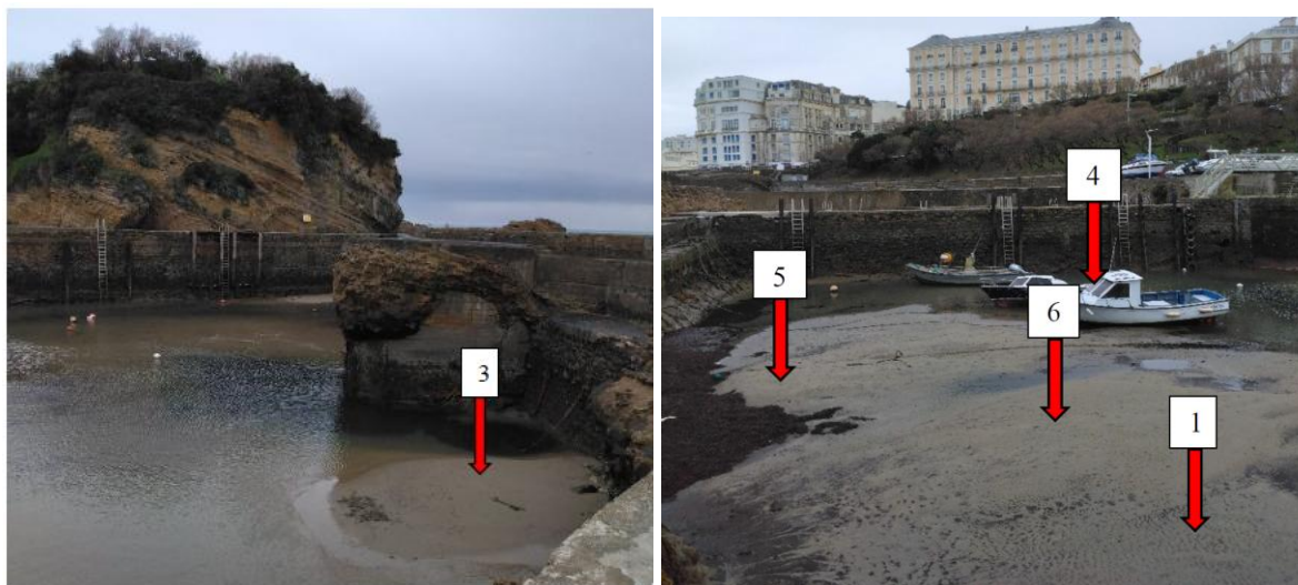
Photo 2 : Photo du sable superficiel au fond du bassin 1 (à gauche) et 2 (à droite) le 07/01/26 (Laboratoires des Pyrénées et des Landes, 2026)
