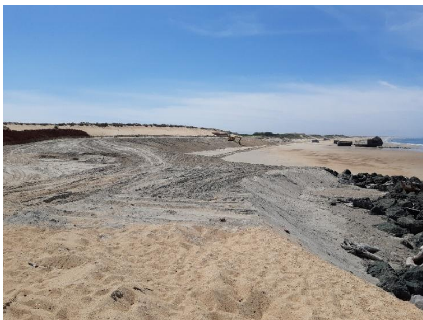
Figure 37 - Exemple du rechargement de sable dragués hydrauliquement et rechargés sur la plage de Santocha à Capbreton (CREOCEAN, 2020)
