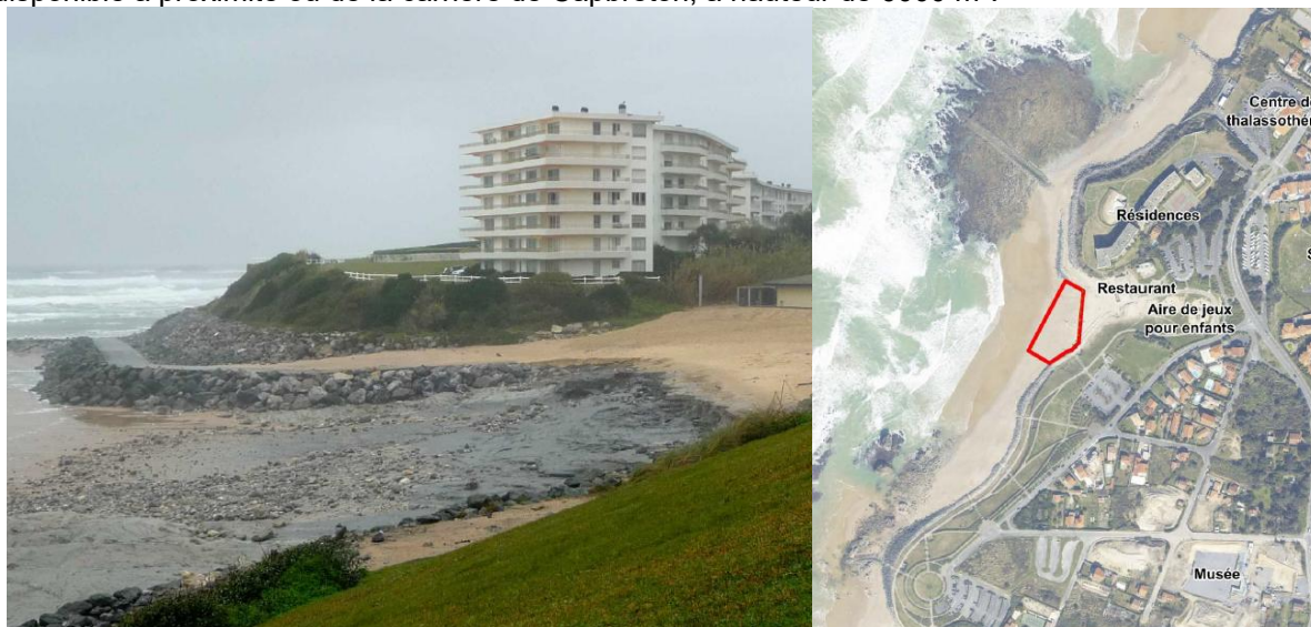
Figure 5 : Photo de la plage de la Milady et périmètre concerné par le rechargement de 2013 (SIAZIM, 2013 ; GEOCIAM, 2013)
