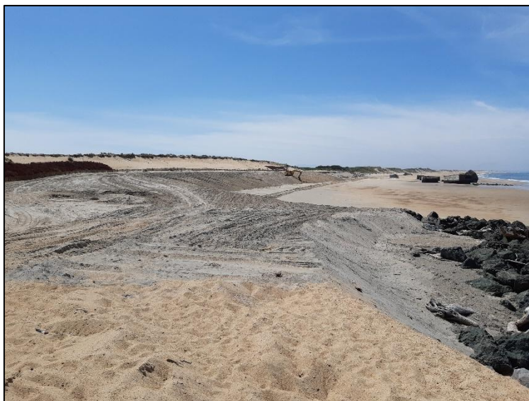
Photo 4 : Exemple du rechargement de sable dragués hydrauliquement et rechargés sur la plage de Santocha à Capbreton (CREOCEAN, 2020)
