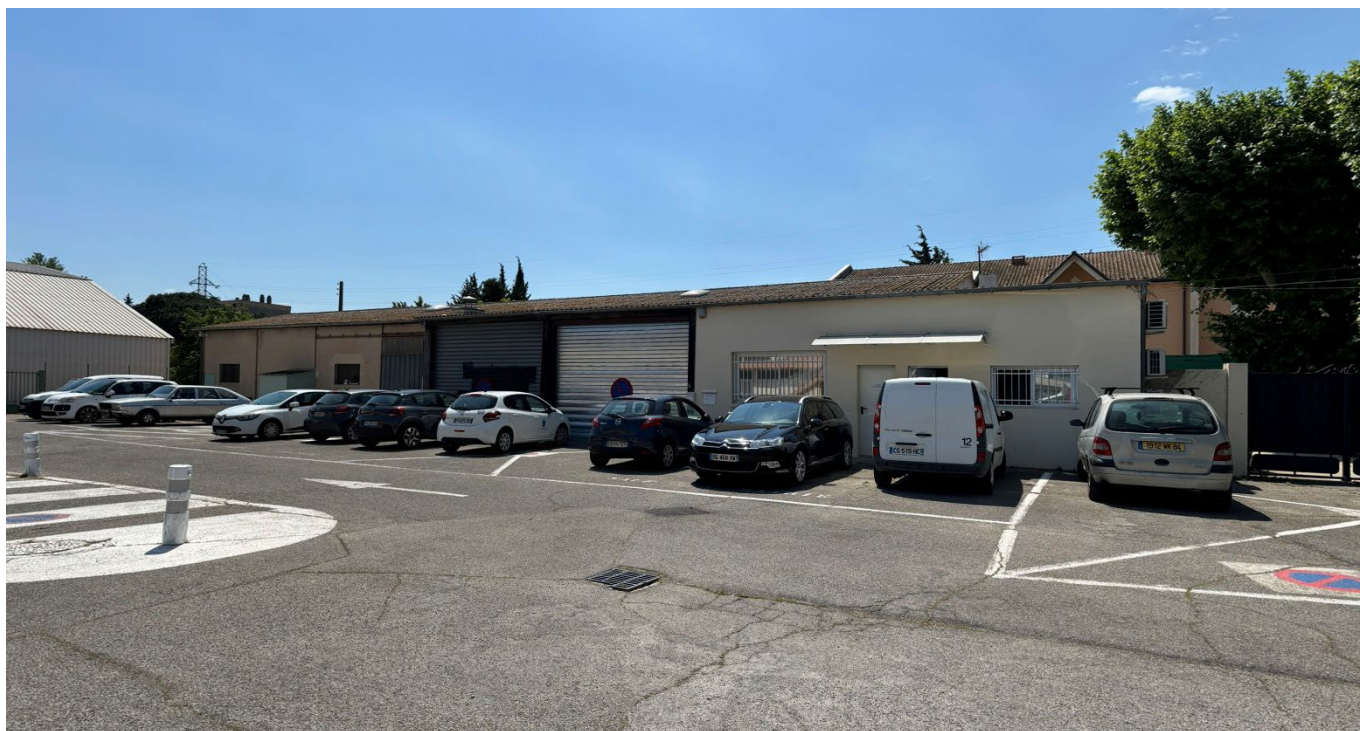
Photographie 13 : Vue Sud-Ouest , depuis la parcelle 0040.
