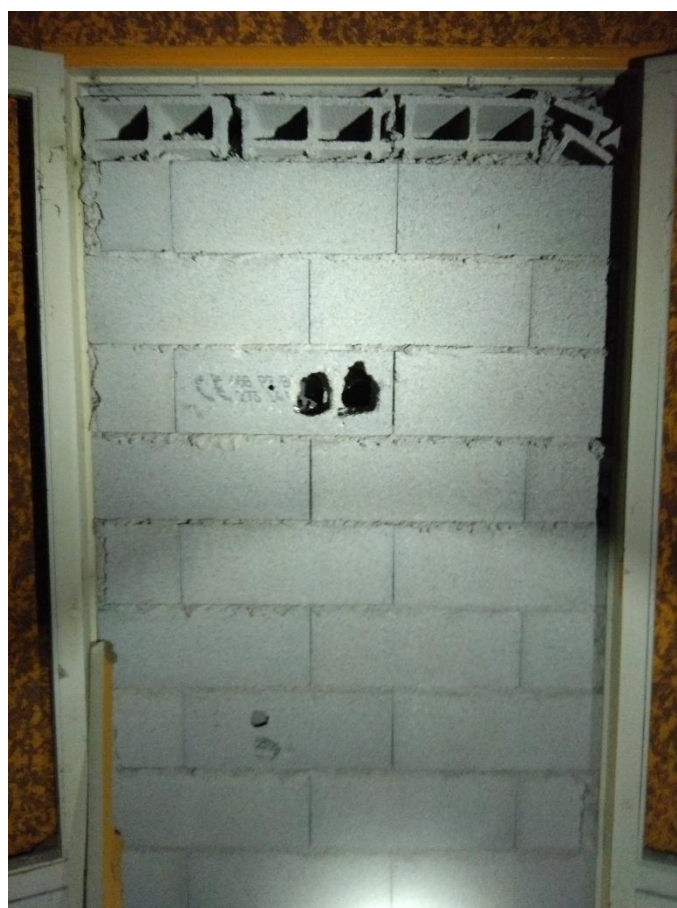
Photographie 1 : infrastructures mis en place pour la sécurité et limité le squat (Source : ENCIS Environnement)
