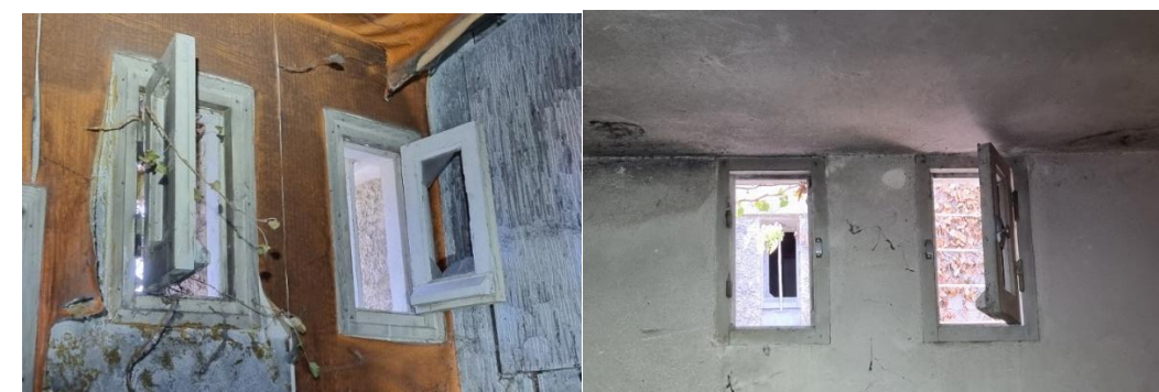
Photographie 5 : Illustrations des nombreuses ouvertures du bâtiment n°3
