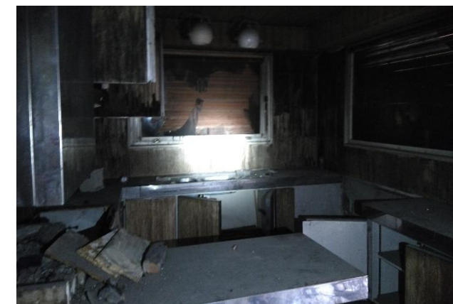
Photographie 4 : "Cuisine" au sein du bâtiment 3 (Source : ENCIS Environnement)
