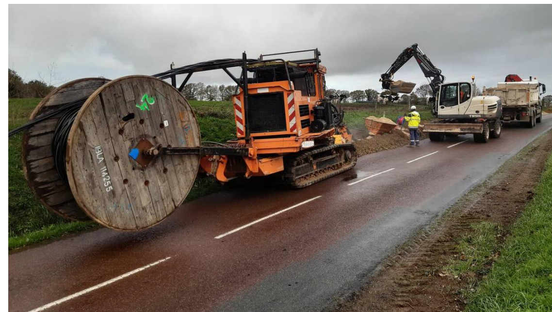
Figure 15 : exemple de travaux de pose de ligne HTA depuis un poste source.
