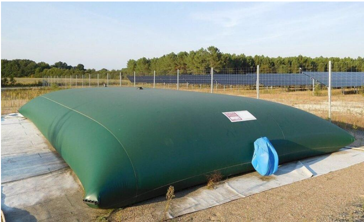
Figure 57 : Citerne incendie (source : maciternesouple.fr)
