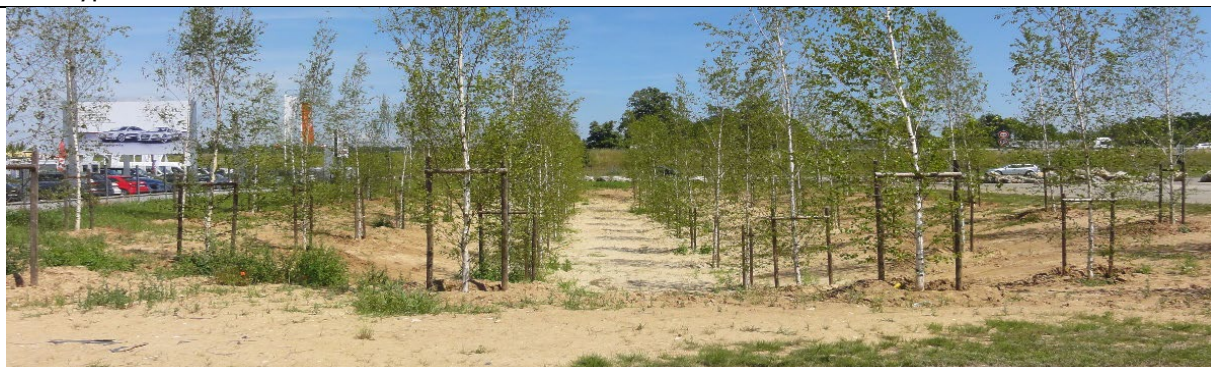
Fig. 14 - Type de bassin de rétention et d'infiltration aérien sec
