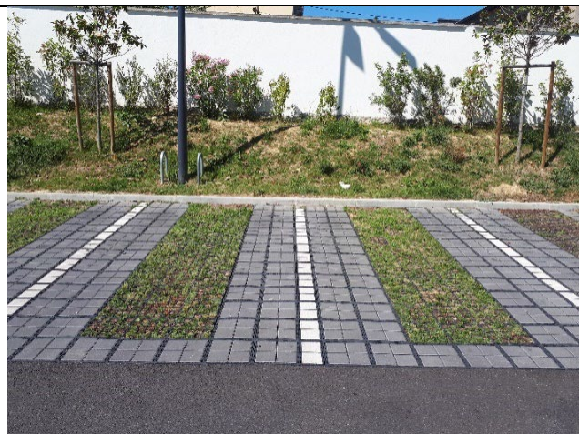
F.11 - Coefficient de ruissellement faible pour les espaces verts xérophiles et les places de parking perméable.
