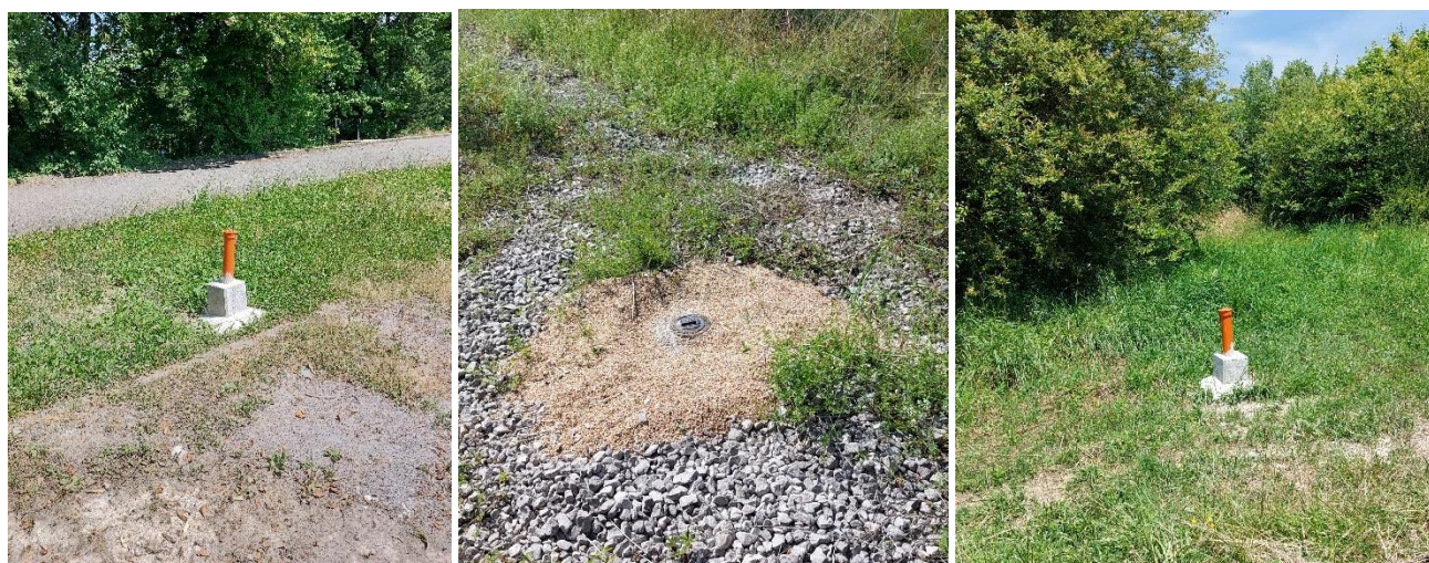
Figure 20 : Photographie des ouvrages piézométriques (source : ECR Environnement, juin 2025)
