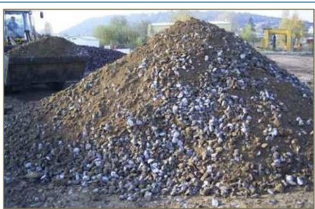
Mélange terre-pierre avant sa mise en œuvre
