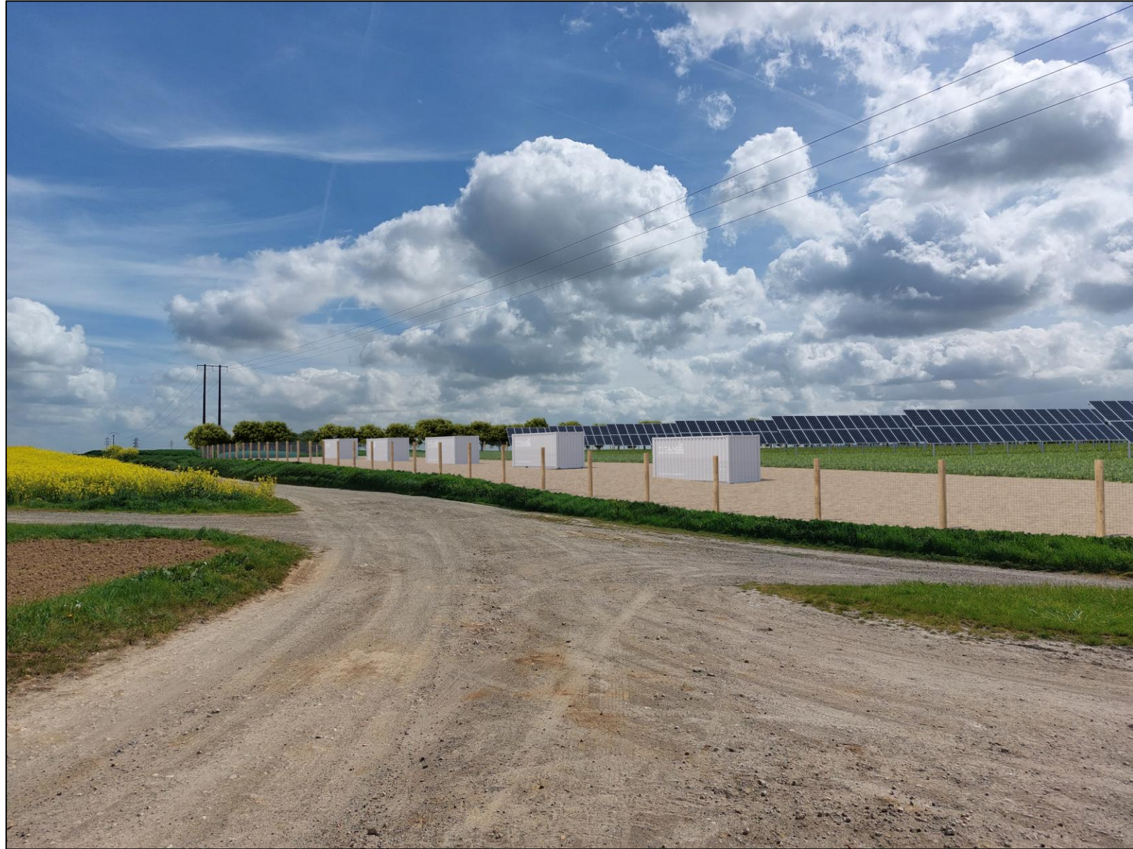
2 – Vu en direction de la ZIP, depuis le nord (Electricité d'Azur, OKA 2026)
