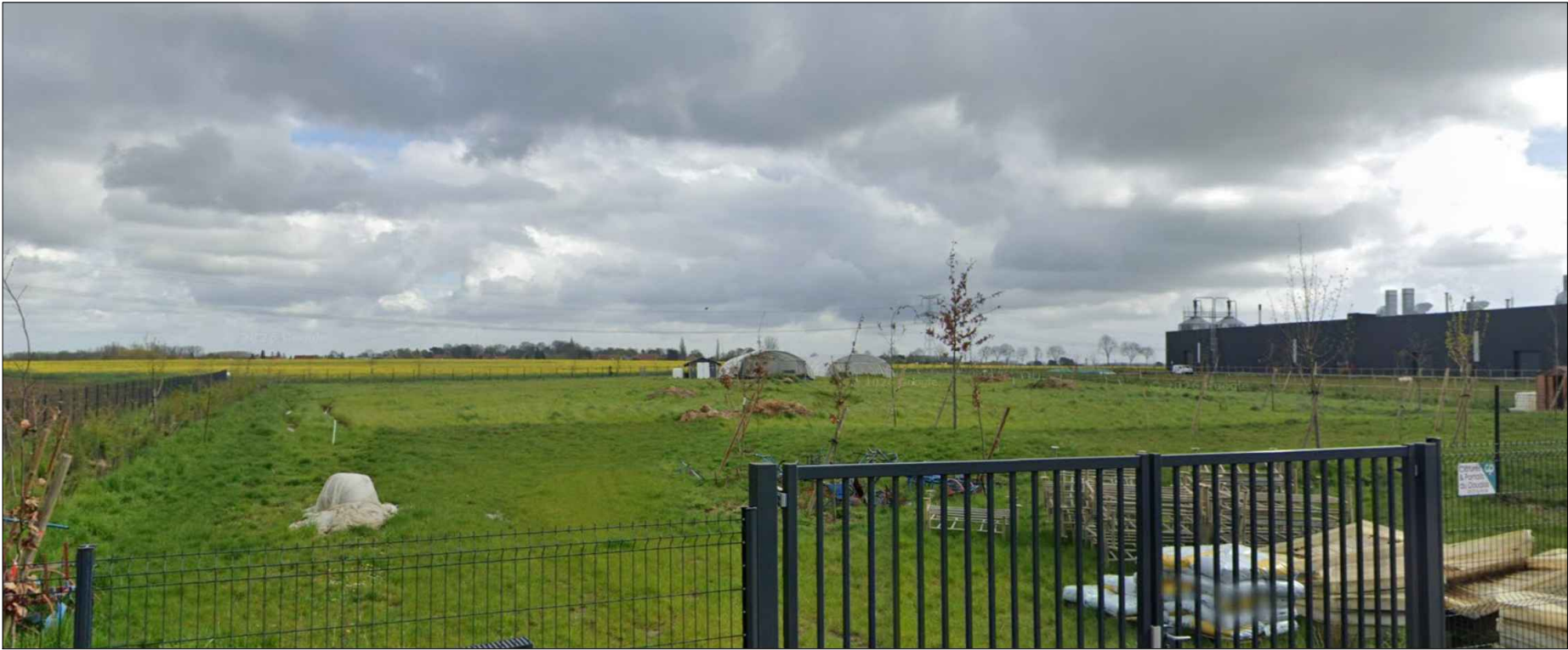
6) VUE FRONTALE SUR INTERIEUR / ENTREE DU SITE
