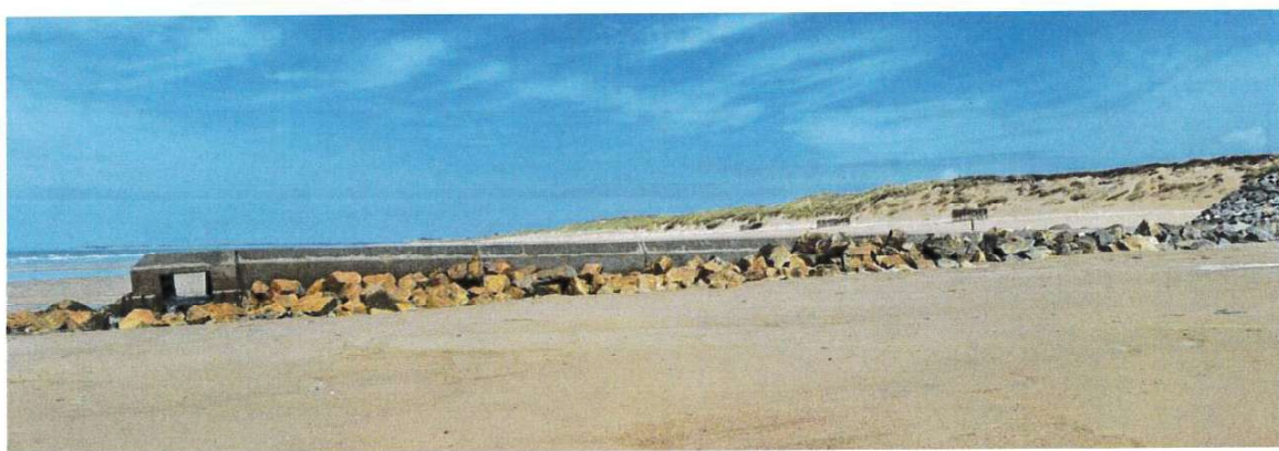
Figure 8 : Canal de rejet (2). Source : ARTELIA mai 2026
