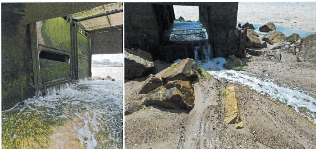
Figure 11 : Tête du canal de rejet (5). Source : ARTELIA mai 2026
