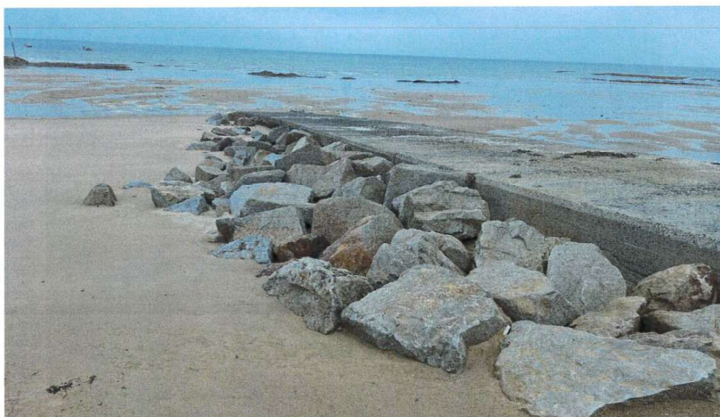
Figure 12 : Cale nord (6). Source : ARTELIA mai 2026
