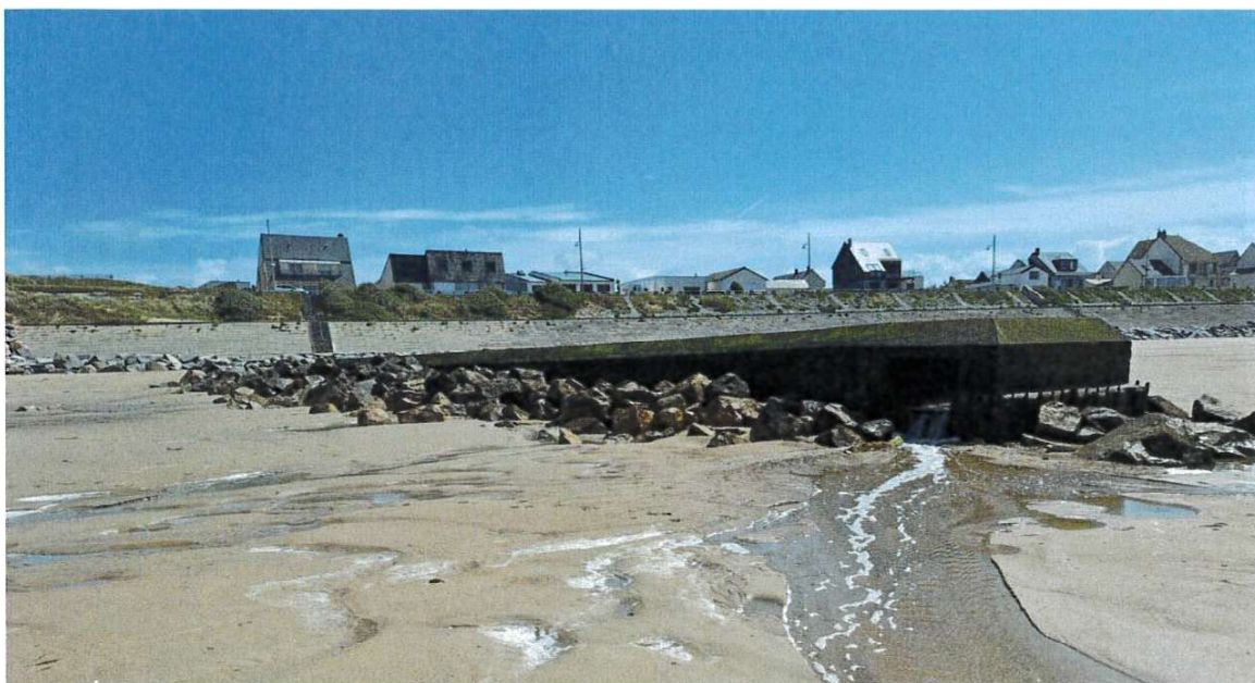
Figure 9 : Canal de rejet (3). Source : ARTELIA mai 2026
