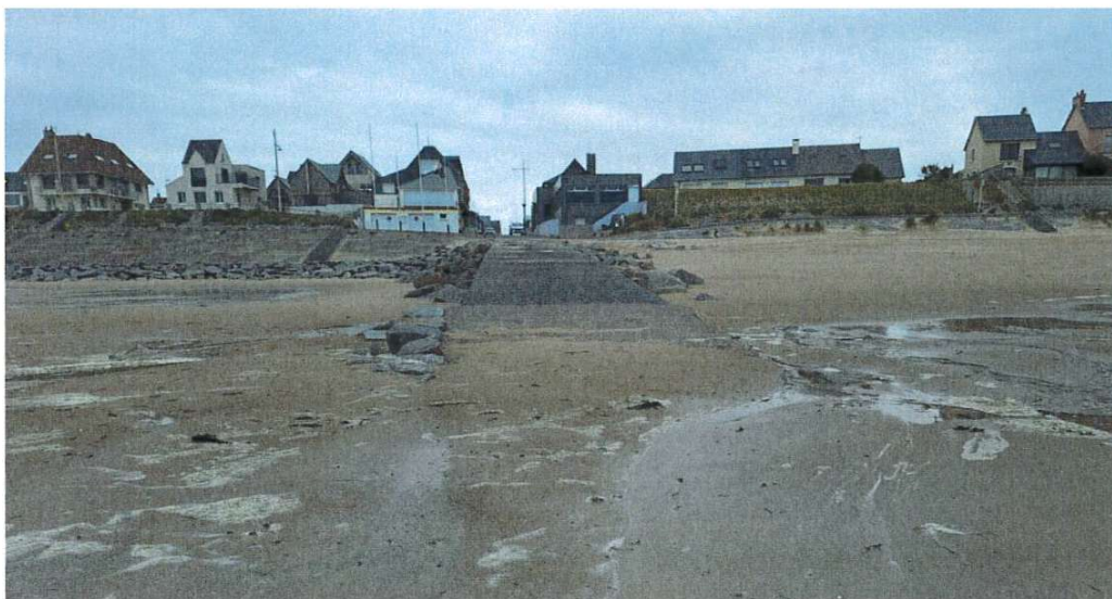
Figure 13 : Cale nord (7). Source : ARTELIA mai 2026
