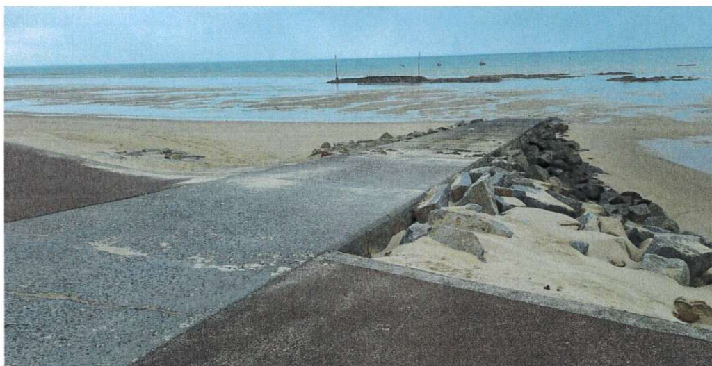
Figure 14 : Cale nord (8). Source : ARTELIA mai 2026
