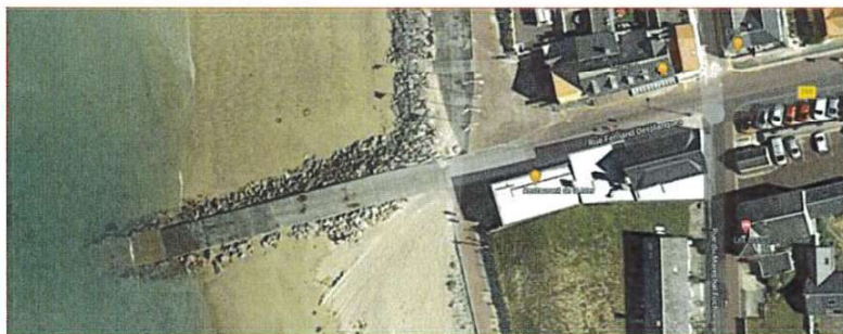
Figure 36 : Cale Nord (à l'extrémité D94)
