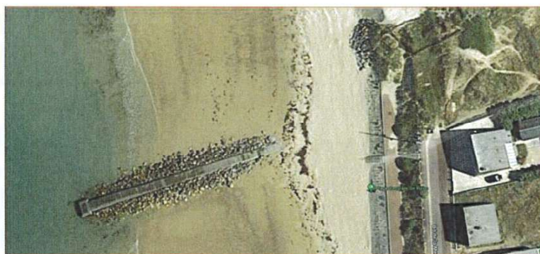
Figure 32 : Canal de rejet des EP
