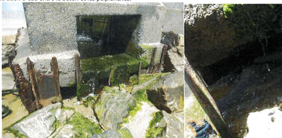
Photo 1 : Exutoire - vue générale et en sous-face
