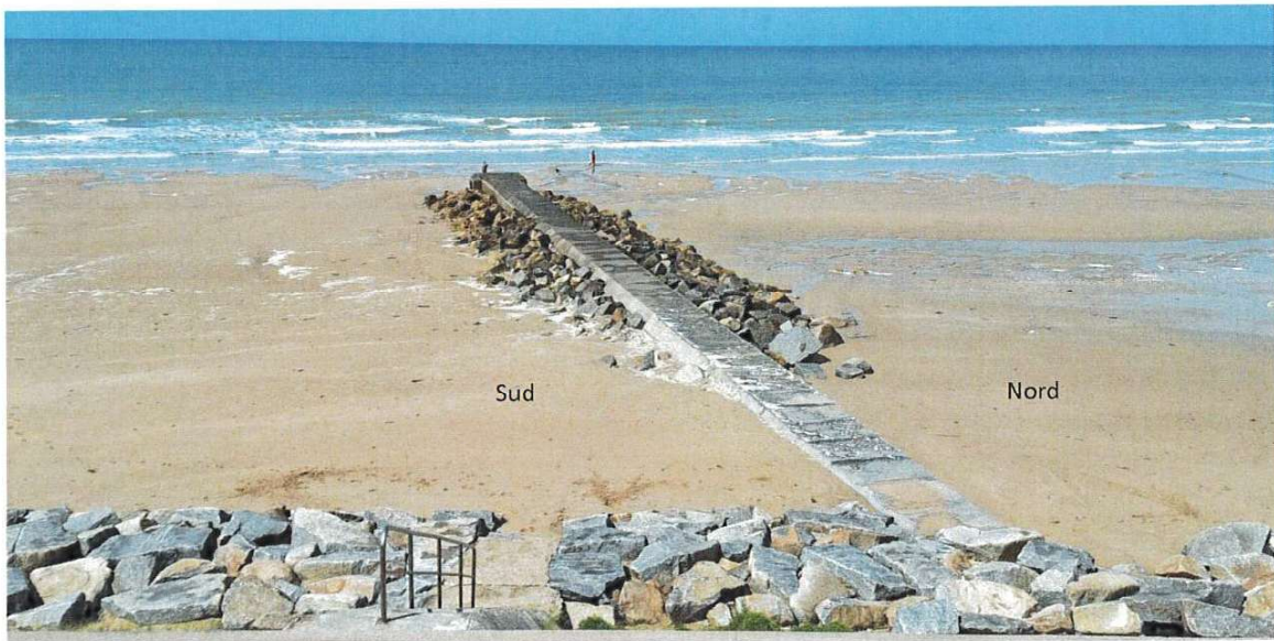
Figure 39 : Canal de rejet. Source : Artelia
