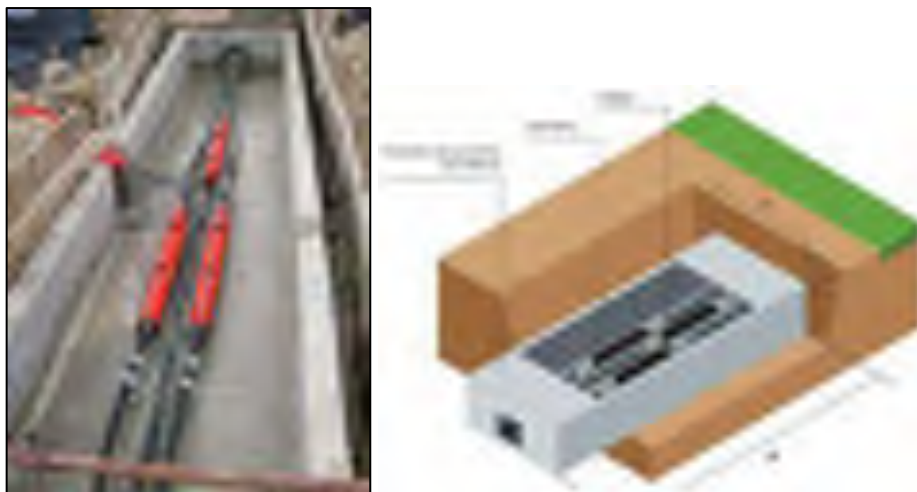
Illustration 27 : Chambre de jonction avant fermeture
