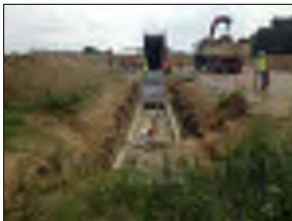
Illustration 28 : Chambre de jonction et puits de terre au premier plan
