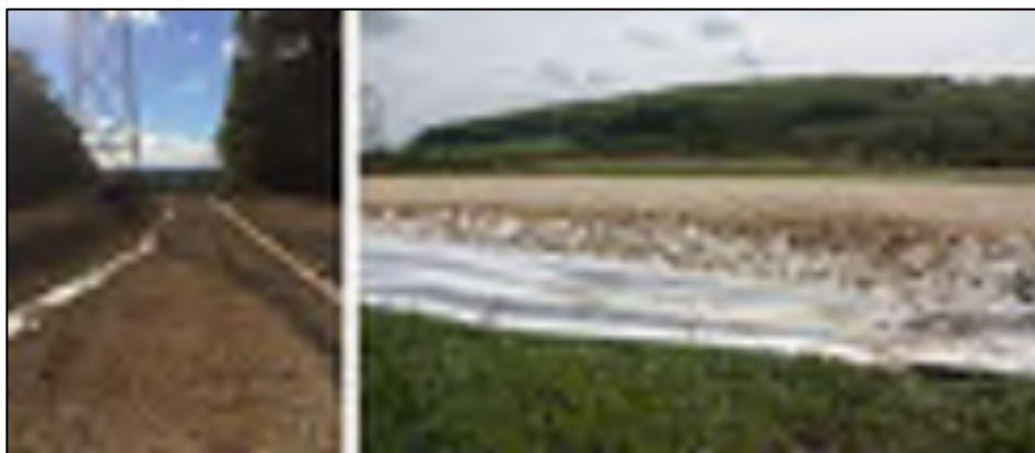
Illustration 17 : Exemples de pistes réalisées avec décapage de la terre végétale et mise en place d'un géotextile recouvert de cailloux (à gauche) ou en surélévation (à droite)
