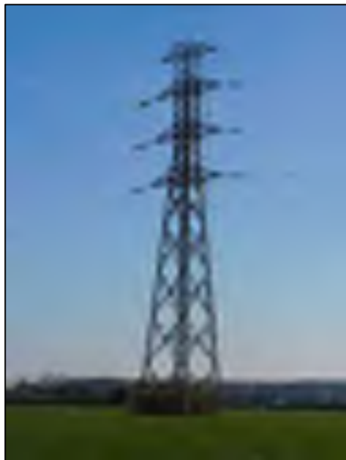
Illustration 11 : Pylône 37 de la ligne existante à 225 000 volts DECHY-GAVRELLE
