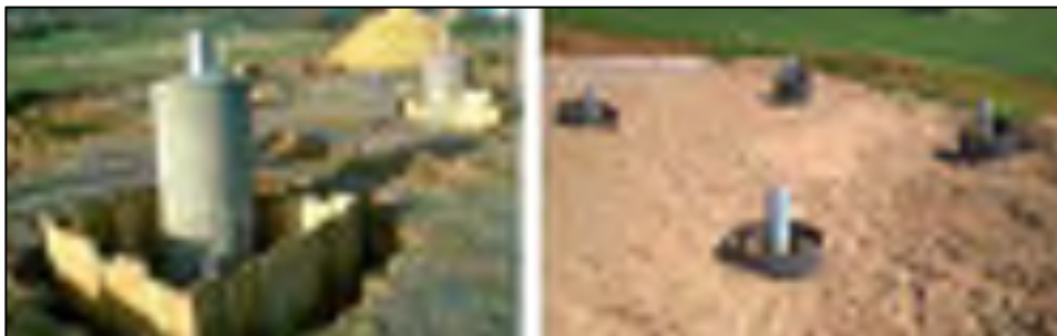
Illustration 19 : Fondations superficielles à gauche et fondations spéciales avec micropieux à droite
