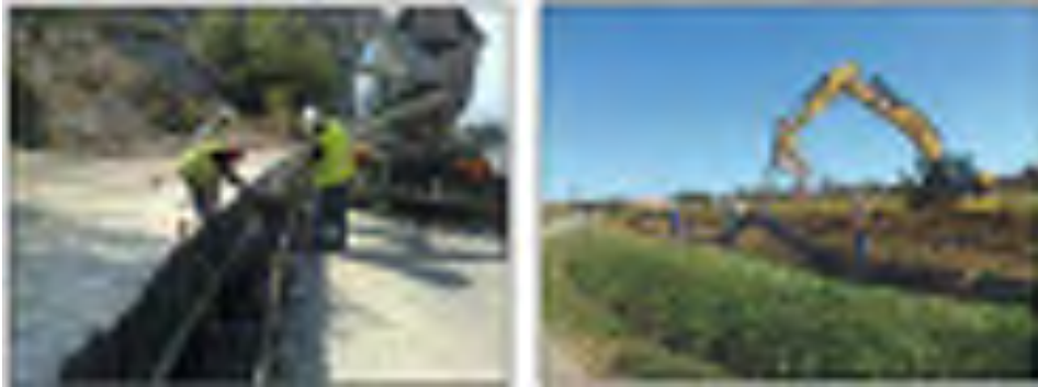
Illustration 32 : Coulage béton (à gauche) et pose des fourreaux PEHD en pleine terre (à droite)
