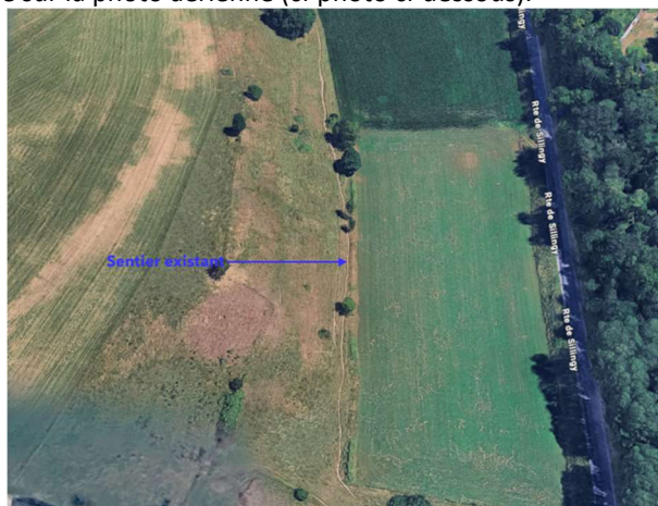
Sentier existant en partie Sud de l'ER35 ©Google
