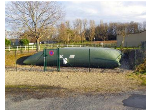
Figure 6 : Exemple de réserve incendie
