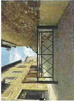
Figure 24 : Barrière à pied embarqué ajustable avec clé rendue prisonnière ou libre à l'ouverture (Source : MERLIN – 2024)
