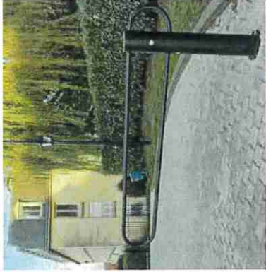
Photo 4 : Barrière pivotante, un pied fixe, goupille avec cadenas antillénie ou cadenas pompiers (Source : MERLIN – 2024)
